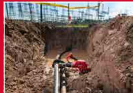
Otvorená konštrukcia čeluste poskytuje najjednoduchší prístup ve výkopu
