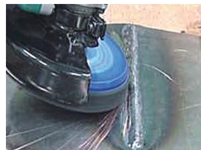
*odstraňovanie farebných defektov po zvaroch
