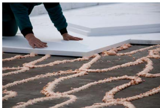
4 Lepení první vrstvy izolantu
