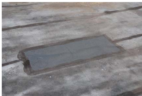
2 Očištění a oprava nerovností
