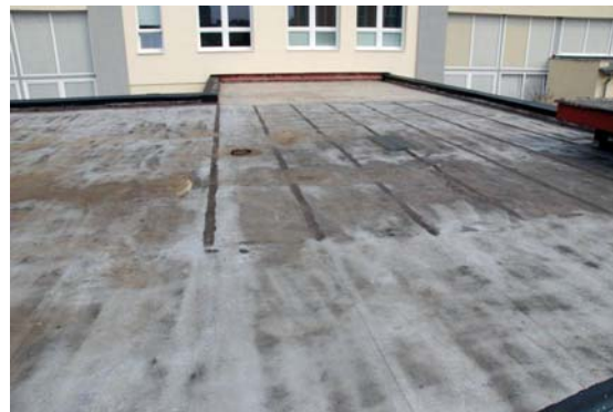
3 Aplikace na původní krytinu
