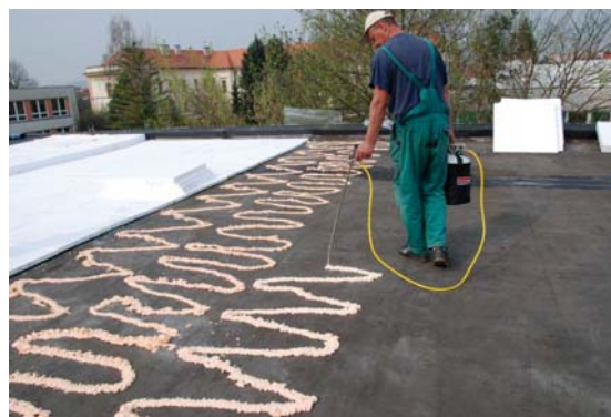
3 Aplikace na původní krytinu
